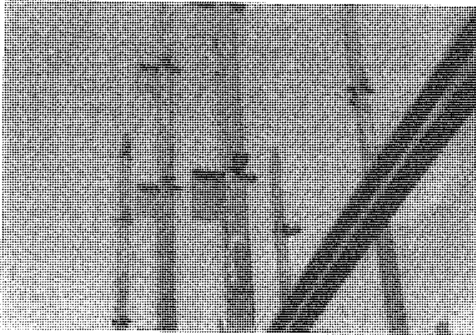
شکل ۹-۶۱ نصب و واداشتن ستون‌ها.
